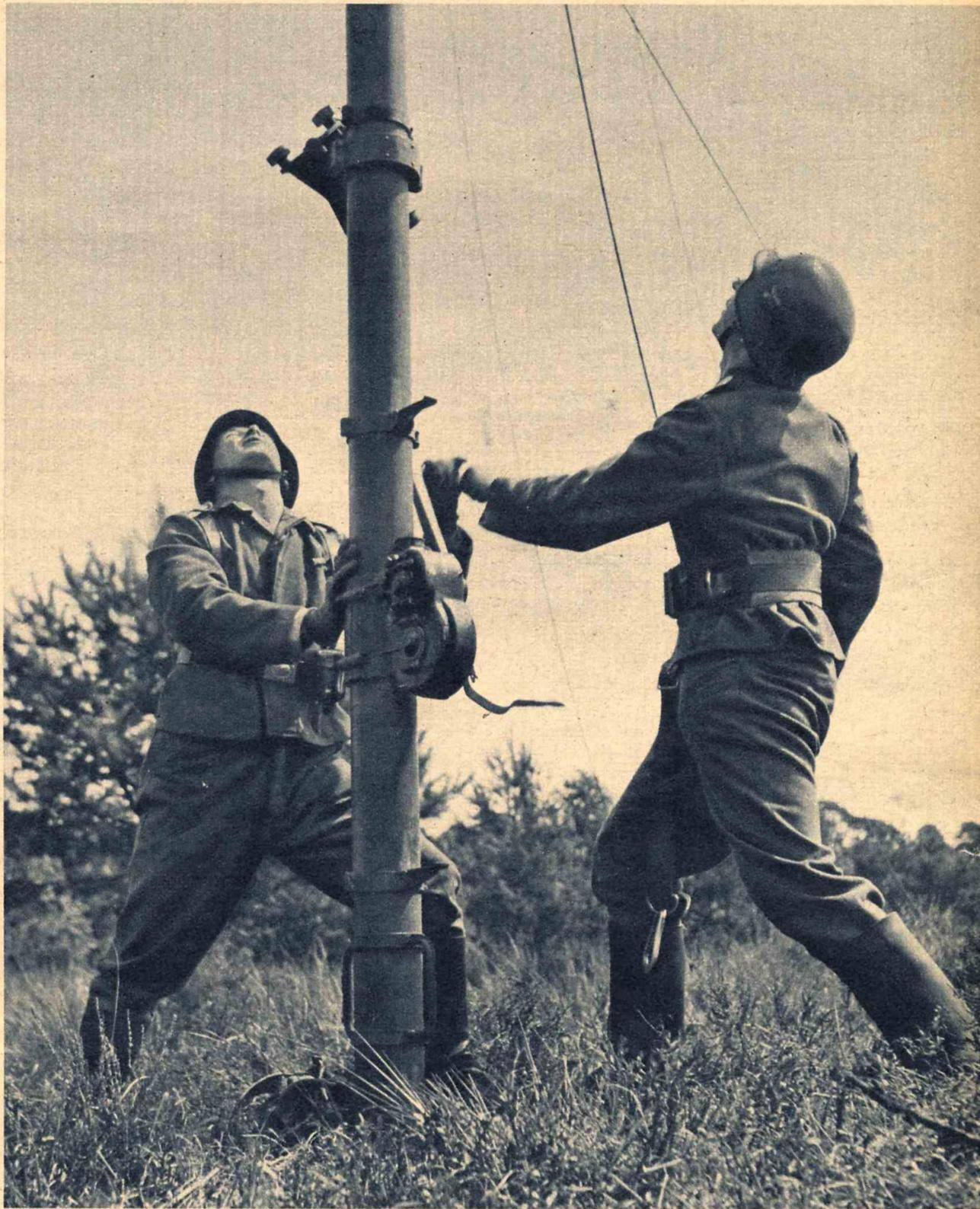
Eine andere Funkstelle ist in offenem Gelände eingesetzt worden. Hier ist die Errichtung eines Antennenmastes notwendig
