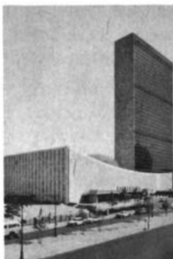
Negative: U. N. Building
